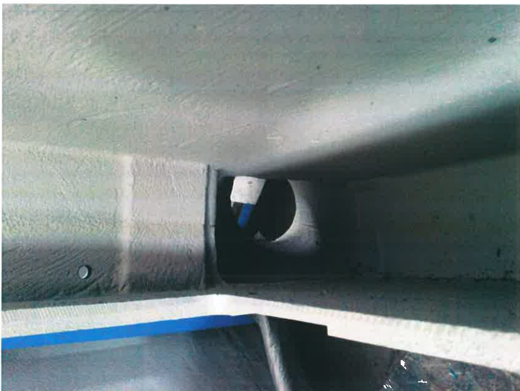
Rys. 1.8. Widok tylnej części koleby dolnej - widoczna chropowatość powierzchni, [opracowanie własne].
